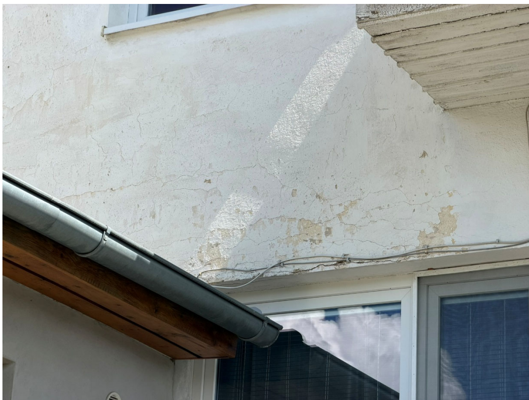
Vnější fasádní omítky
