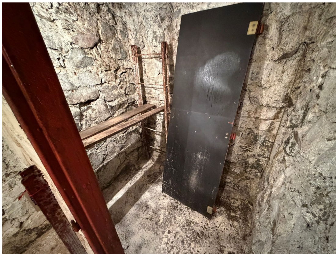
Prostory 1.PP garáže
