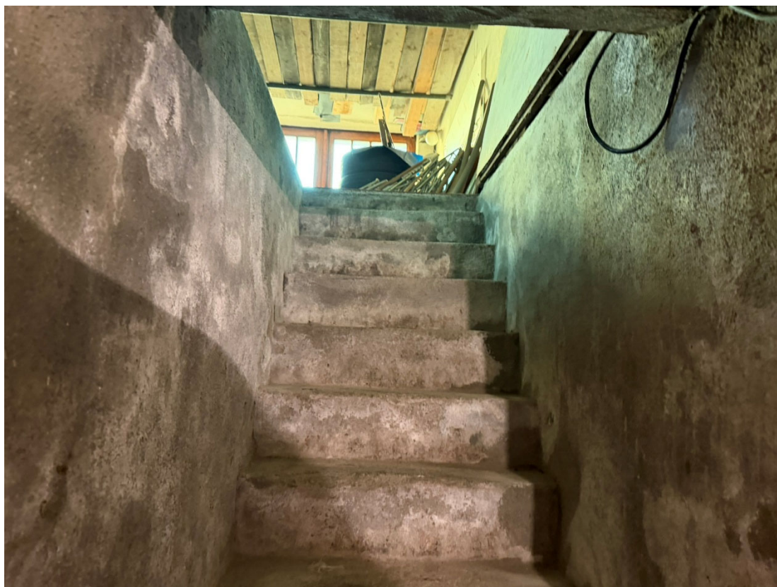
Schody do 1.PP garáže
