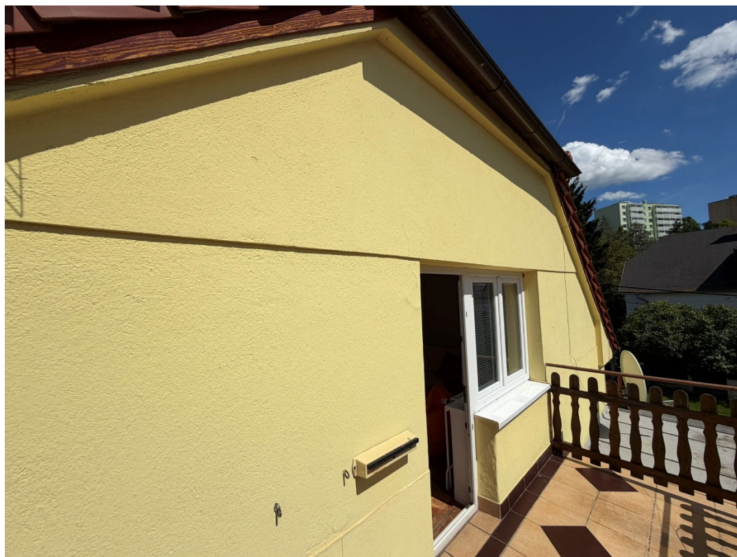
Vnější fasádní omítky
