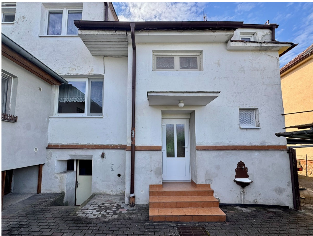
Vnější fasádní omítky
