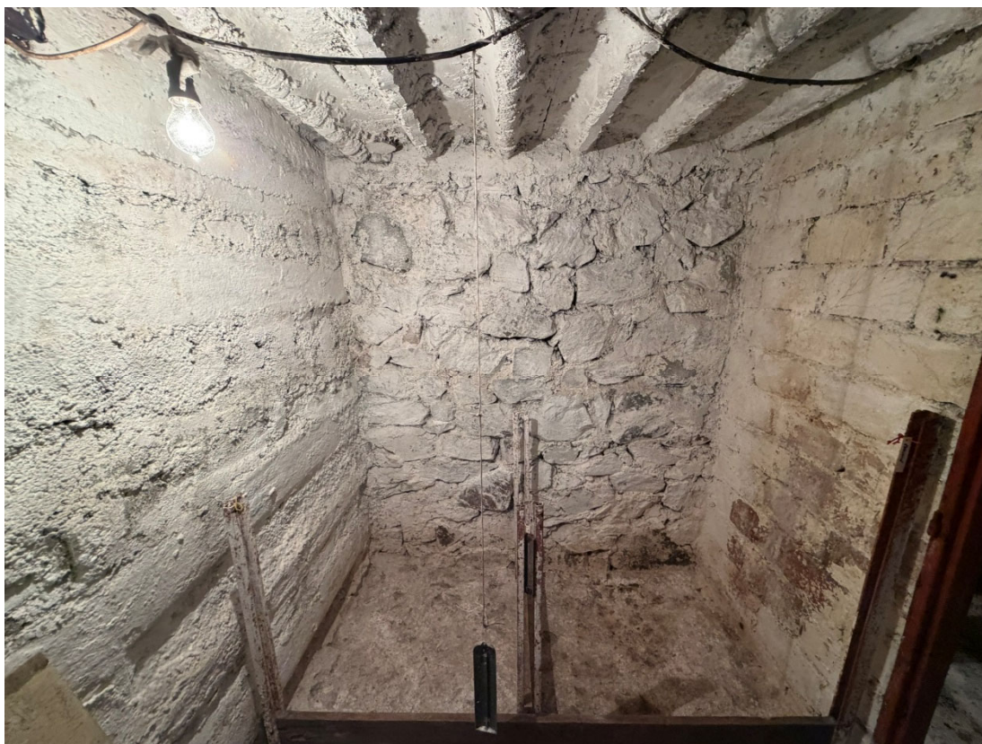
Prostory 1.PP garáže
