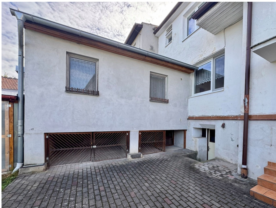
Vnější fasádní omítky
