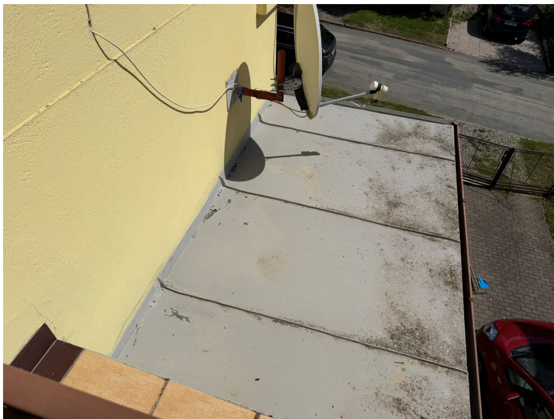
Střešní krytina nad zádveřím
