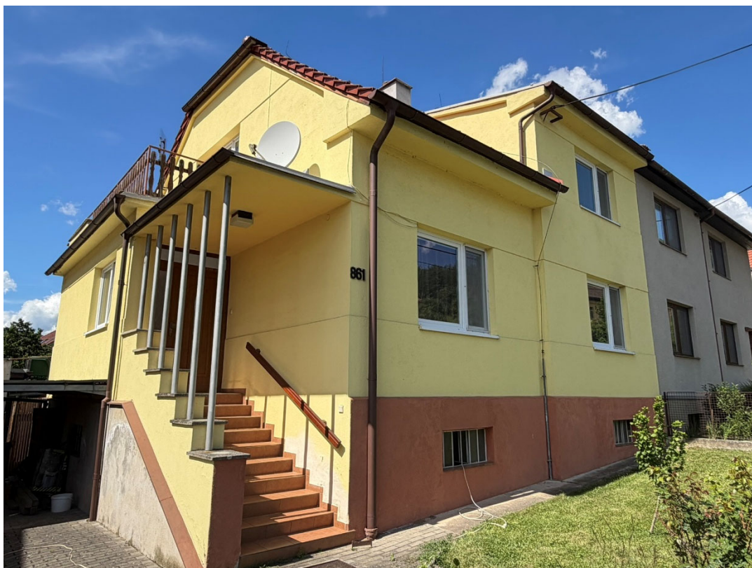
Vnější fasádní omítky
