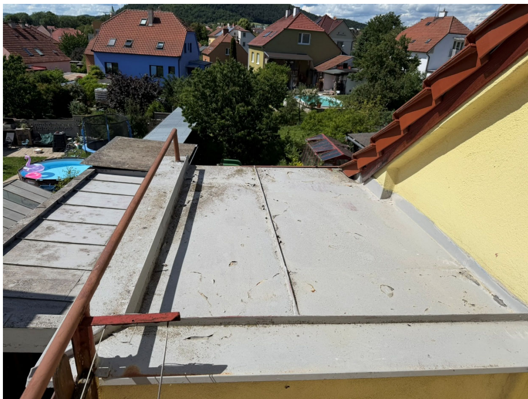
Střecha nad toaletou
